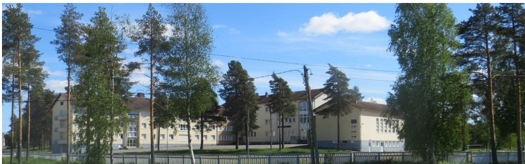
Purkuluvan saanut koulurakennus. Purkujäte käytetään kaava-alueen maantäyttöihin.
