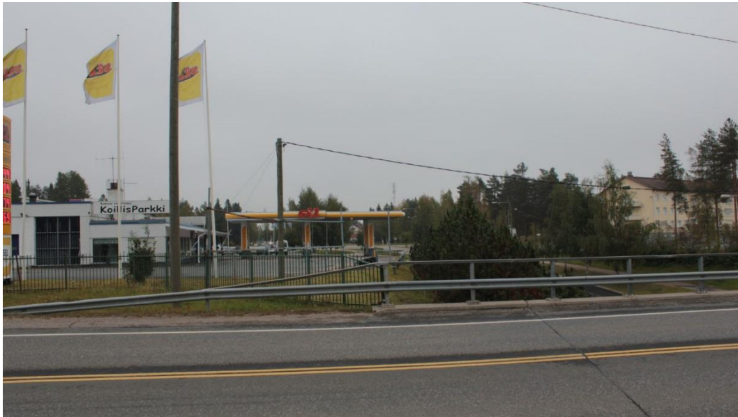
Huoltoaseman ja purettavan koulun välinen alikulku valtatieltä katsottuna.
